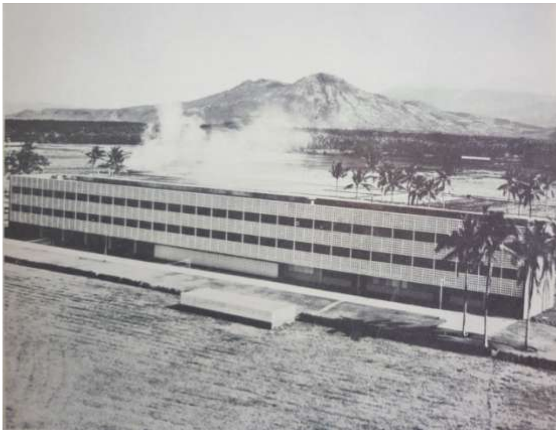
Fig. 7.3 y 7.4. Instalaciones (abajo) y Consejo de Administración del IRRI en 1962. De izquierda a derecha, sentados: Sinco (Filipinas), Damle (India), Harrar (F. Rockefeller), Gozon (Filipinas), García (Filipinas). Atrás, Shen (Formosa), Kihara (Japón), Chakrabandhu (Tailandia), Chandler (Director) y Hill (F. Ford) (Stakman, 1969: 288).
