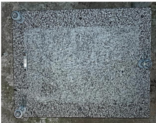
Figura 26 . Nivelación losas.
