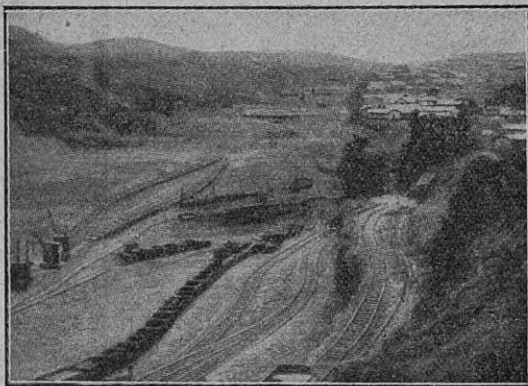
Los trabajos de excavación en la zanja
