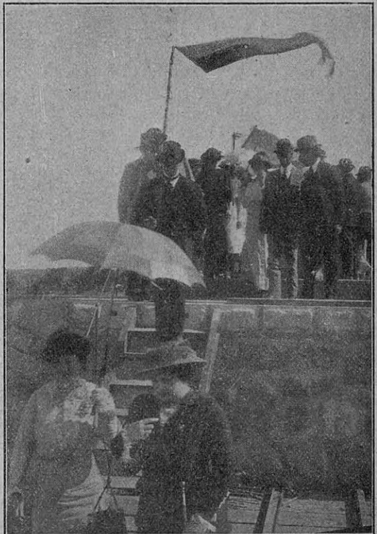
El ministro de obras públicas visitando las obras del dique
