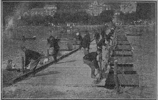
El batallón de ingenieros tendiendo un puente sobre el río "Meuse"
