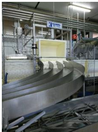
Ilustración 8. Volcado de la cuajada por la rampa para su moldeo.
