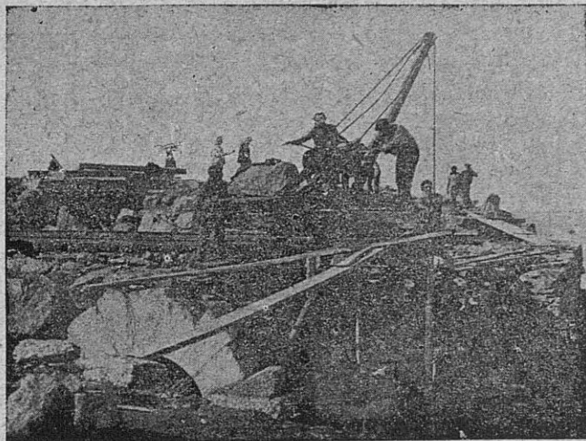
UNA BATERÍA, DE MONTEFARO
