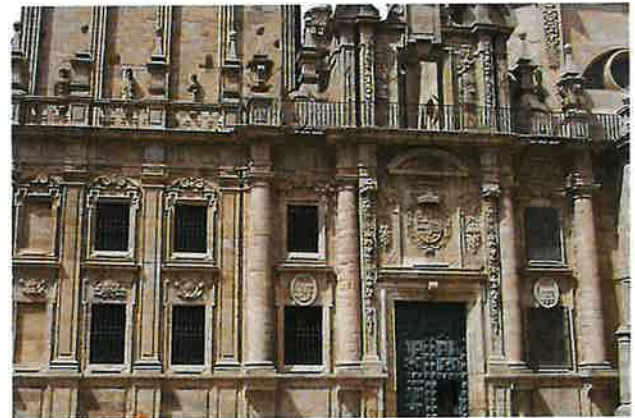
Fig. 4. Pórtico da Quintana e exterior da sancristía. Foto do autor
