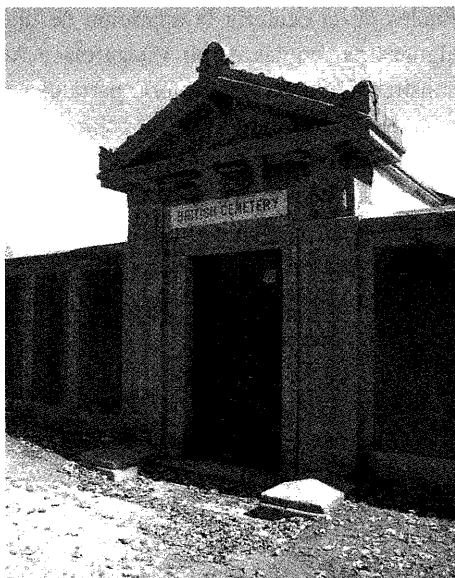
Fig. 10. Cementerio Británico (A Coruña).
