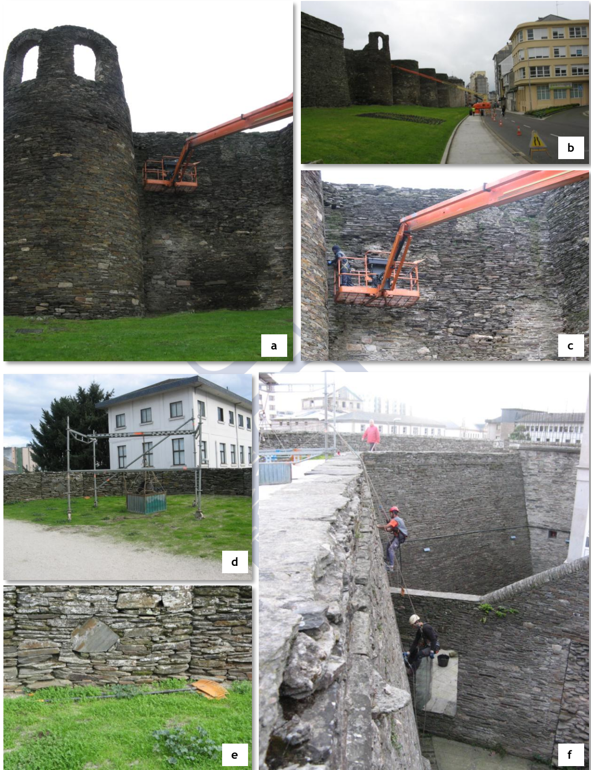
Figura 2.4 Brazo telescópico con cesta elevadora (a, b y c) empleados en los trabajos de limpieza de la vegetación en la zona exterior de la muralla; estructura de anclaje (d), material auxiliar (e) y realización de trabajos verticales en su paramento interior (f) (diciembre 2014).
