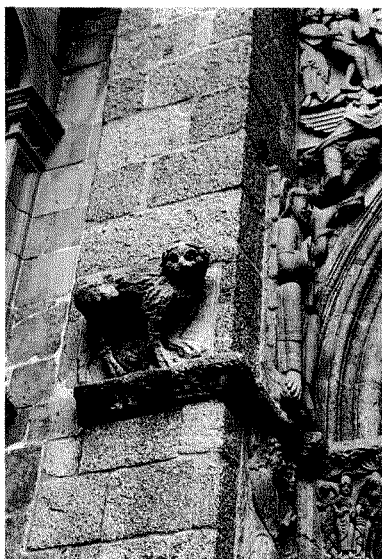
Figura 29. León. Catedral de Santiago de Compostela, Porta de Praterías, contraforte oeste.
