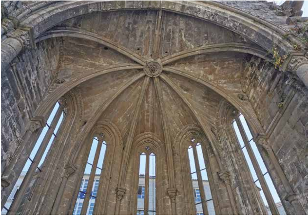
Fig. 50. Cerramento da Capela maior. San Domingos de Pontevedra. Foto actual
