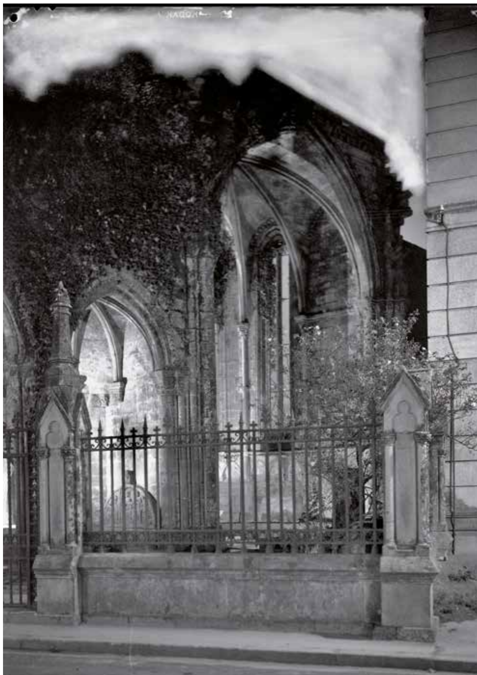
Fig. 9. Joaquín Pintos (1881-1967). Vista parcial da cabeceira e cerramento do convento de San Domingos de Pontevedra
