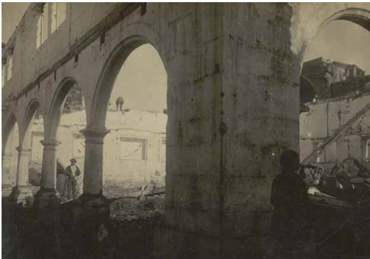
Fig. 26. Francisco Zagala (1842-1908). Demolición do claustro do convento de San Domingos
