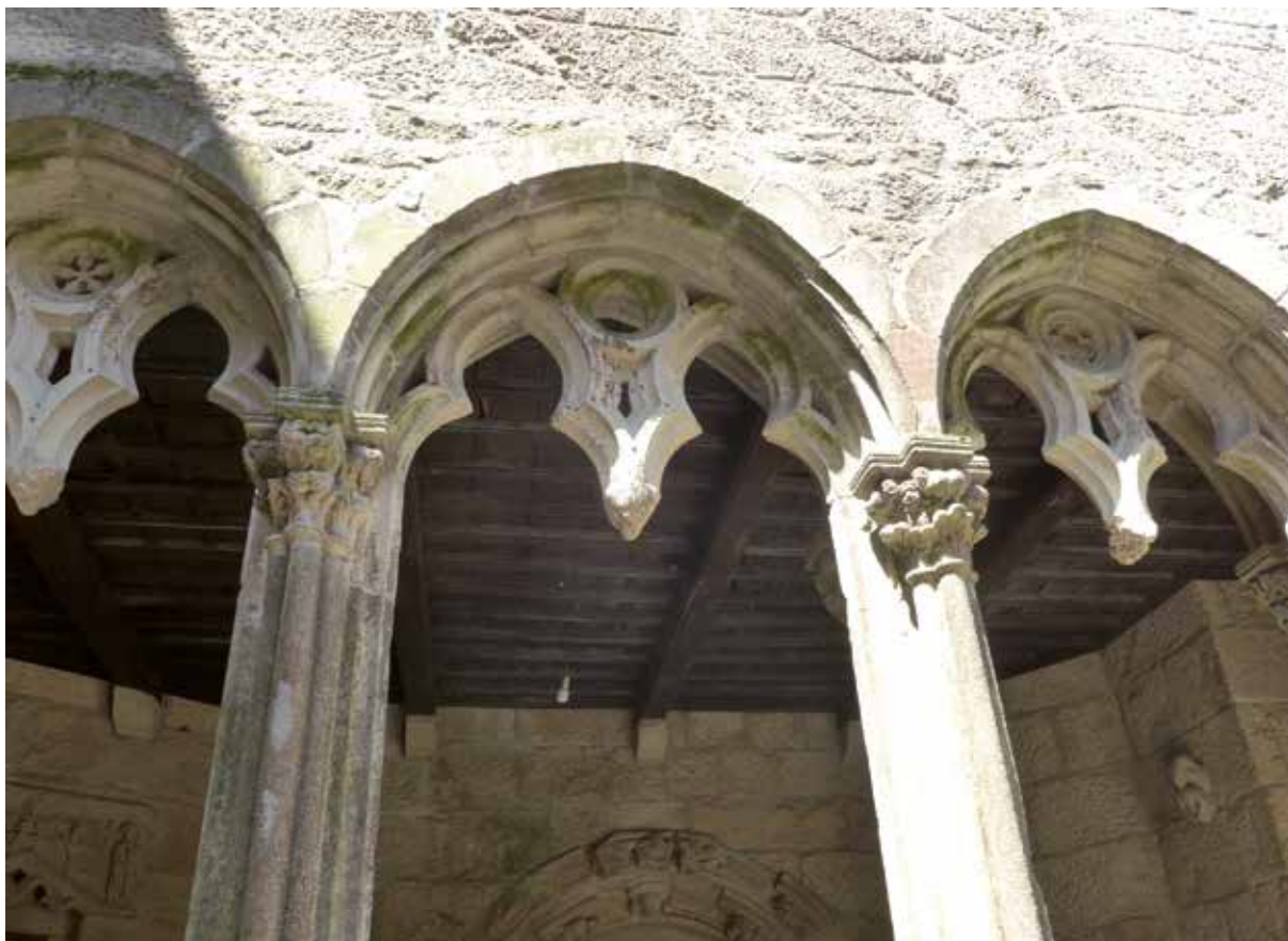
Fig. 54. Arcada da Sala Capitular. Detalle. Foto actual
