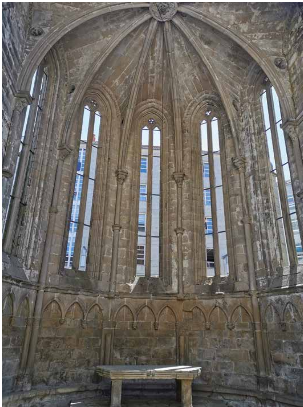
Fig. 11. Capela maior de San Domingos de Pontevedra. Foto actual
