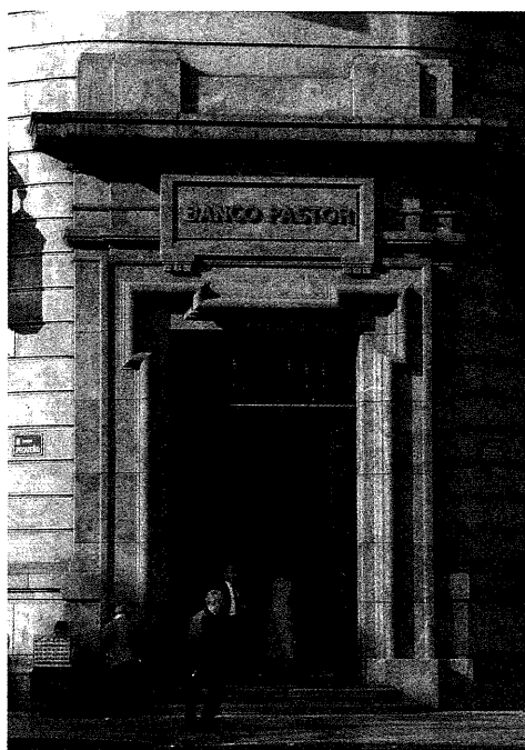
Fig. 5. Detalle de la puerta principal del Banco Pastor de A Coruña (1922). Arquitectos, Antonio Tenreiro y Peregrín Estellés.
