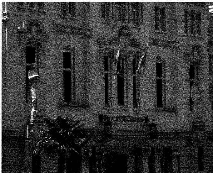
Fig. 3. Detalle de la entrada principal del Palacio de Justicia de A Coruña (1909-1928). Arquitectos Julio Galán y Ricardo Boán.
