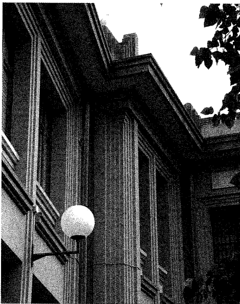
Fig. 13. Detalle de la fachada del grupo escolar Curros Enríquez de A Coruña (1930). Arquitecto, Luis Martínez Díez.
