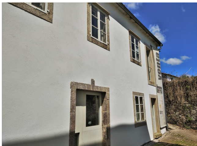
Figura 18: Fotografía actual da casa rehabilitada por Verde Urban
