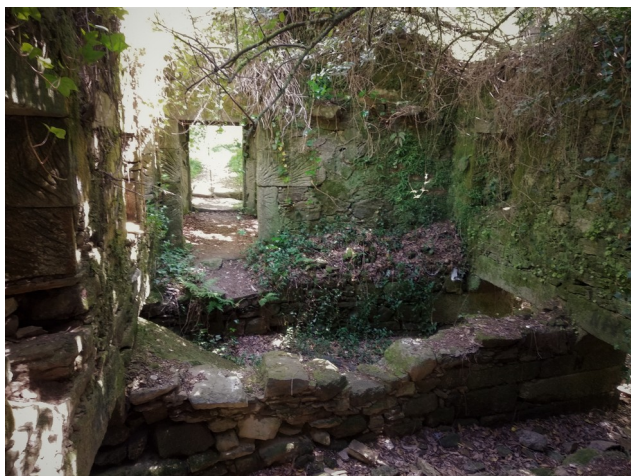
Figura 14: Estado interior dos Muíños de Ponte Sarela
