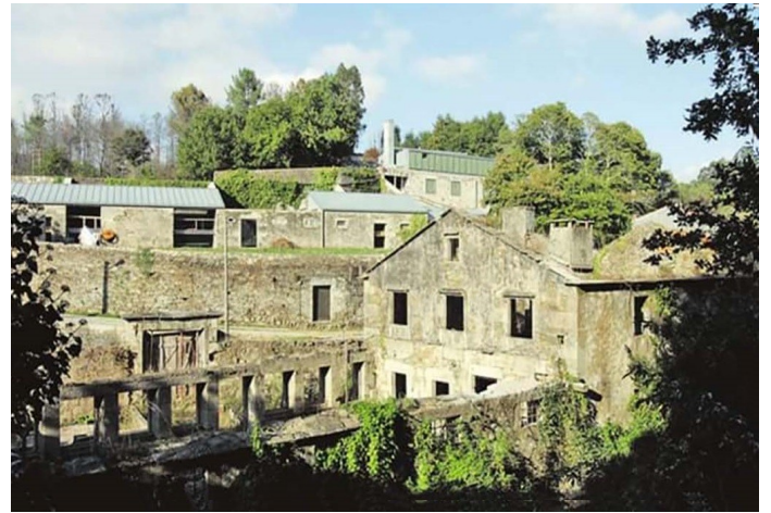
Figura 6: Fotografía do complexo fai uns anos
