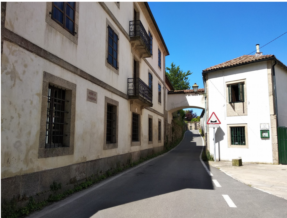
Figura 2: Actual estado do paso superior ao nivel
