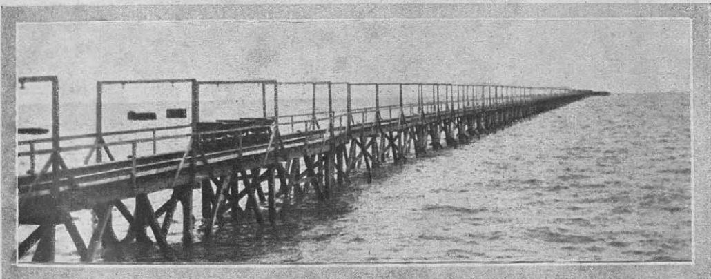
Muellecito construido para el transporte de los materiales destinados a la torre de toma y por el que corre un "tractor" eléctrico
