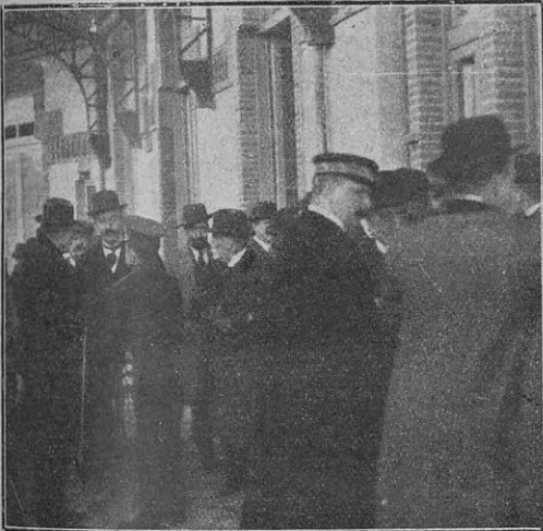
Inauguración del ferrocarril de Barcelona a Martorell
