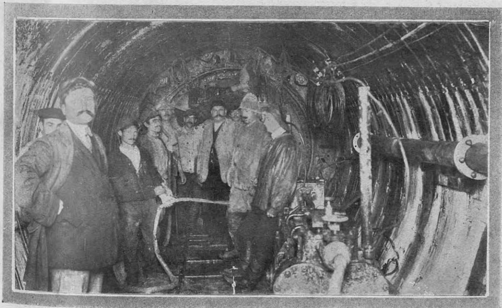
Perforando los últimos sesenta metros del túnel.—La “avanzada” se efectúa por medio de aire comprimido y por un escudo de hierro movido por doce gatos a presión hidráulica
