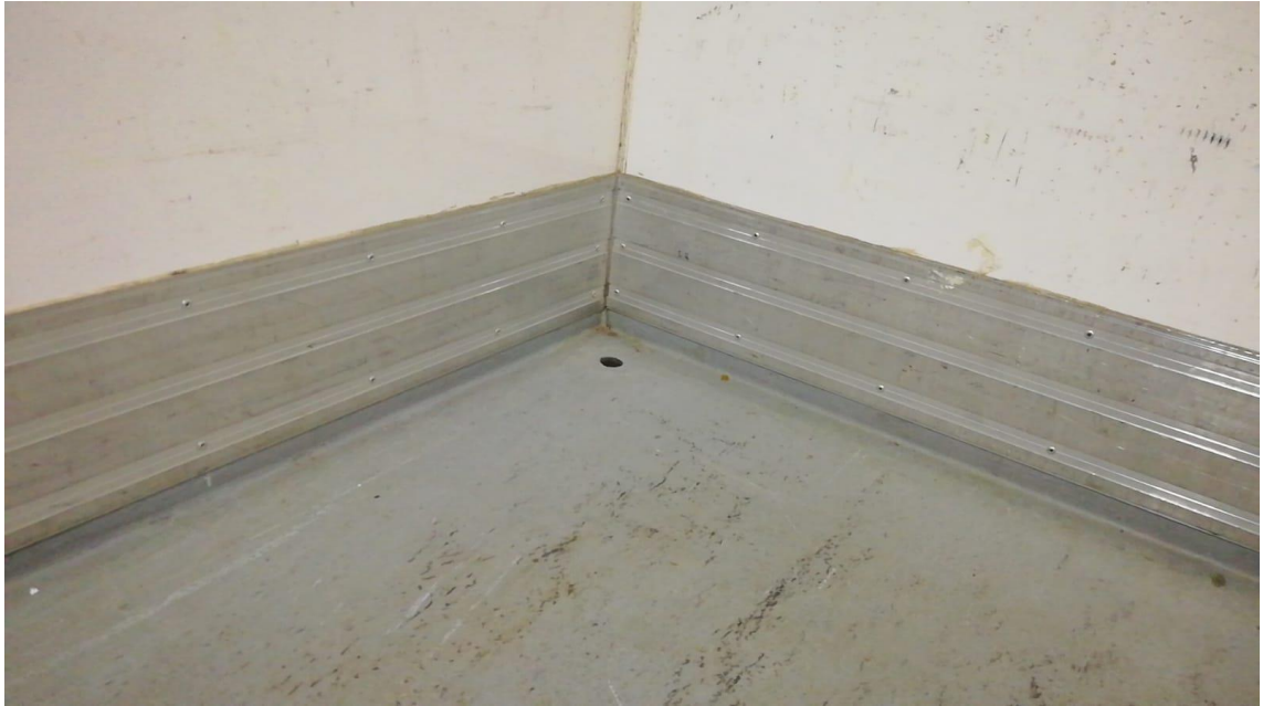
Figura 7. Detalle zócolo e desaguadoiro interior [Fonte propia]
