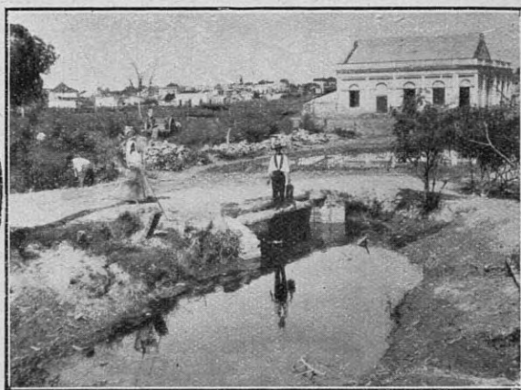
Tucumán.—Pantano en el boulevard Avellaneda, costado de la vía del F. C. C. N., que ha sido terraplenado
