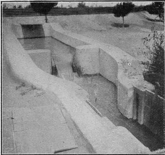
Obras de riego. — El medidor principal
