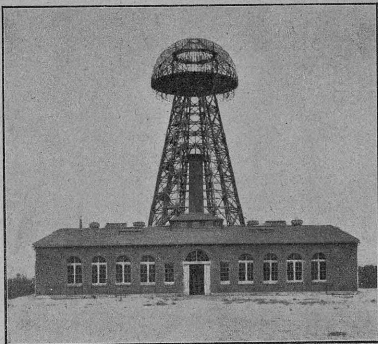
Torre de 55 metros de altura de la estación radienergética instalada por Tesla en Long-Island (Estado de Nueva York), desde donde se transmitirá la energía eléctrica a lejanas distancias
