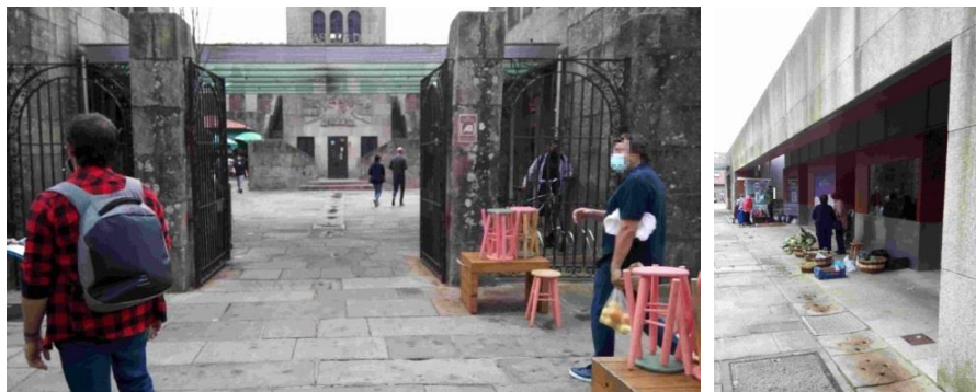
Fotografias 24 e 25 - Telhado que liga as naves e fachada da aula Sociocultural
