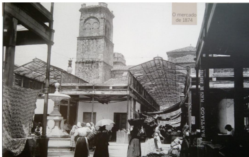
Fotografia 23: “Quatro anos de Obras”
