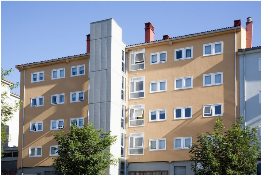
Ilustración 18: Rehabilitación de fachadas e elevadores
