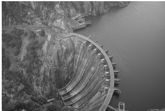
Figura 1. Presa de Aldeadávila (Salamanca) . As presas son un claro exemplo dun problema de hidrostática
