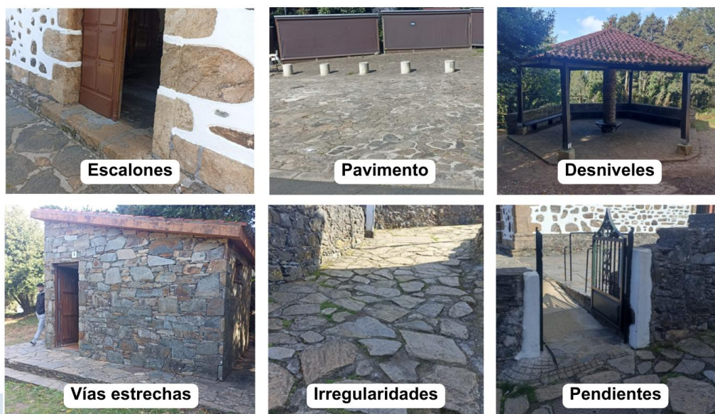
Figura 50. Barreras arquitectónicas no accesibles
