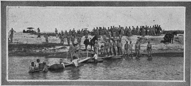
Sujetando los tablones y colocando guarda-lados
