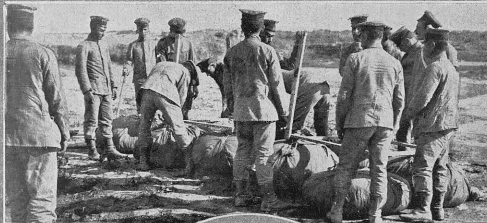
Improvizando una pasarela, en la que se utiliza como flotadores los paños de las carpas
