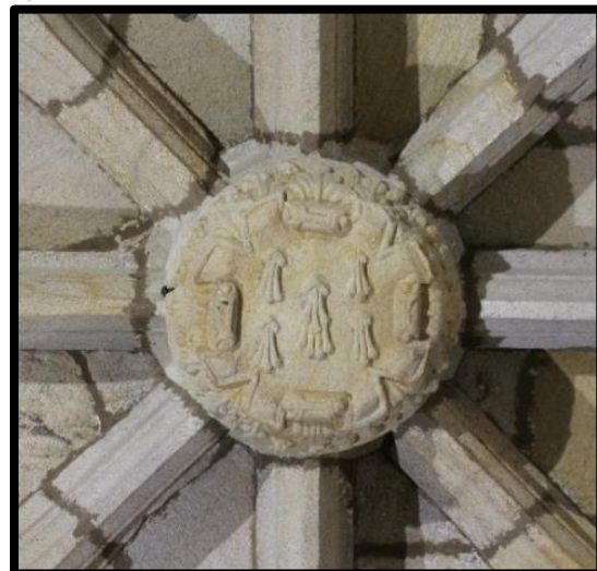
144. Clave de la bóveda
