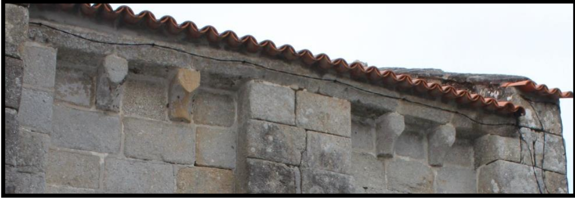
42. San Xoán de Baión. Cabecera. Canecillos del muro sur
