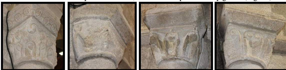
54. Capiteles del ábside
