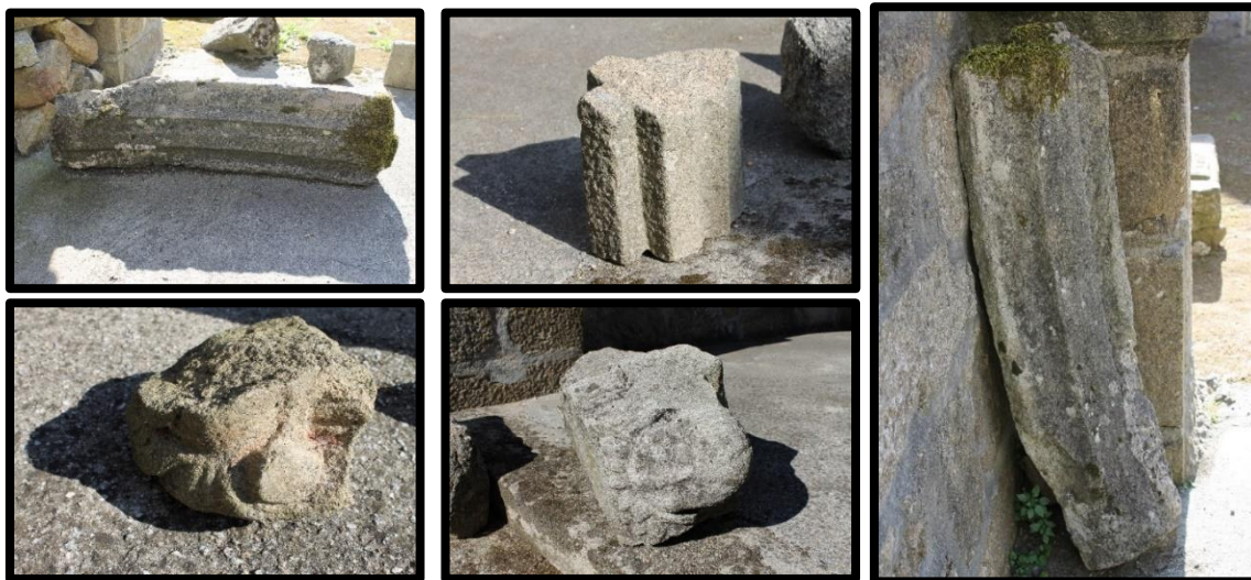
86. Piezas de la bóveda de crucería de la capilla de la Concepción
