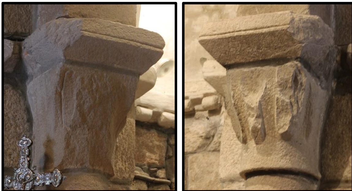
181. Capiteles del ábside
