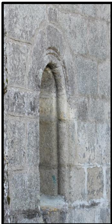
220. Vano del primer tramo, muro norte
