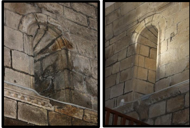
237. Primer y tercer vanos septentrionales de la nave
