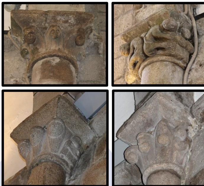
231. Capiteles del ábside
