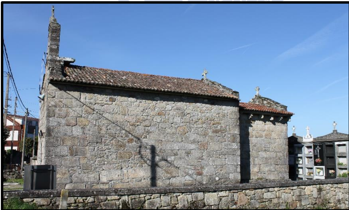
186. Nave de la iglesia
