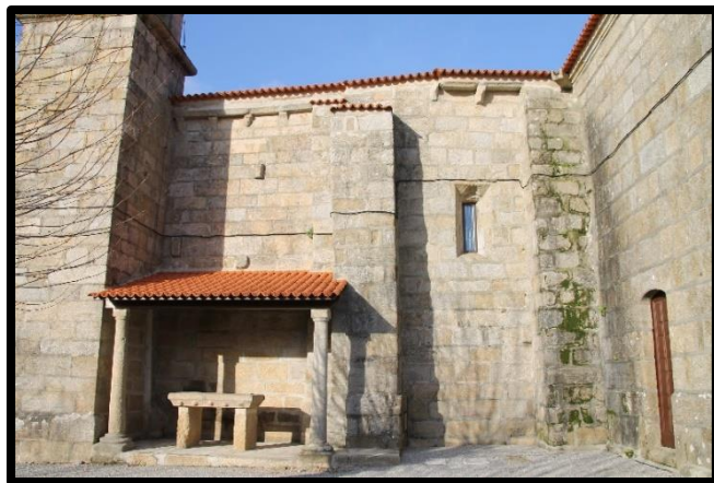
116. Muro lateral de la nave
