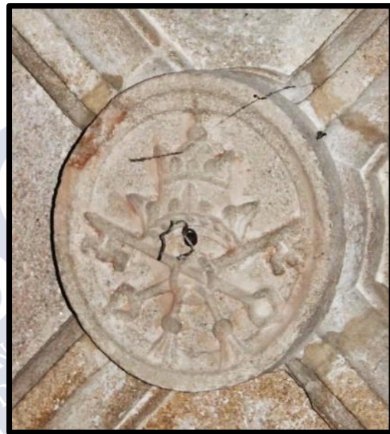
60. Clave de la bóveda
