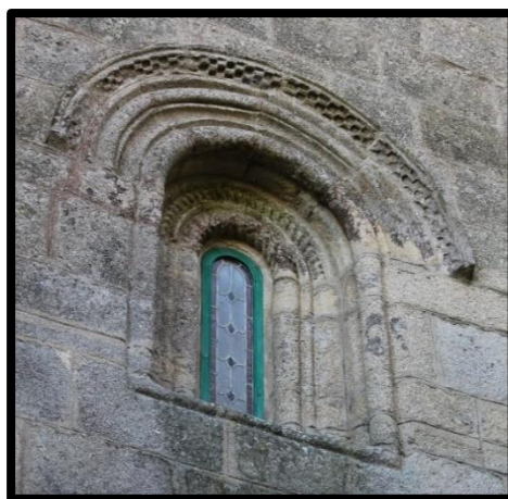
221. Vano del segundo tramo, muro norte
