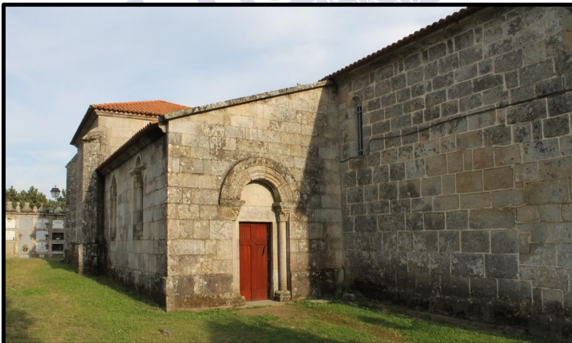
68. Exterior de la capilla del Evangelio
