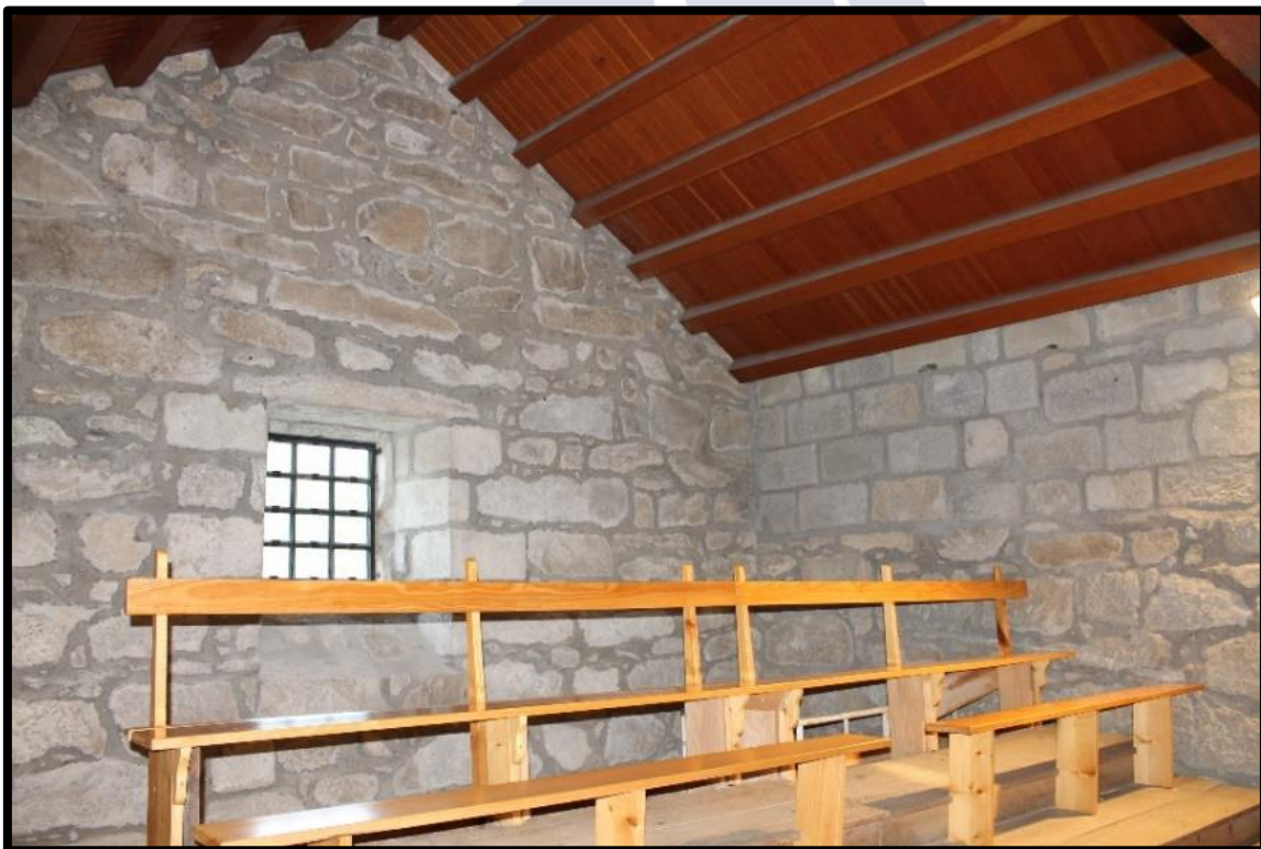
76. Vista del interior de la fachada desde el coro
