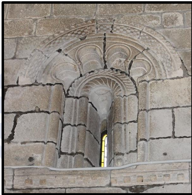
238. Vano central septentrional de la nave
