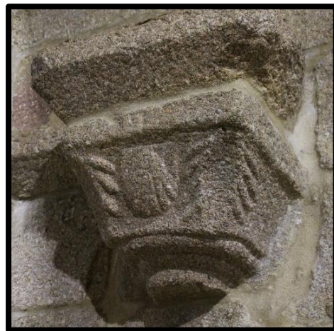
125. Capitel de la nave
