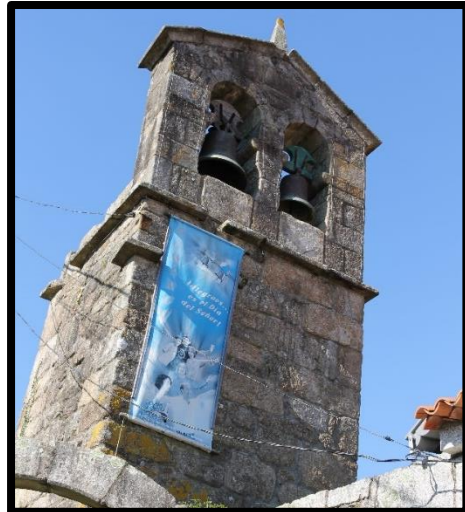
17. Torre-campanario de San Adrao de Vilariño, Cambados
