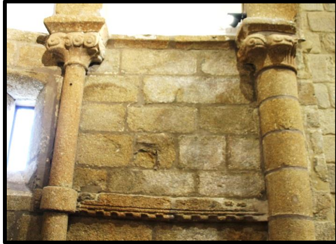
123. Columnas interiores e impostas
