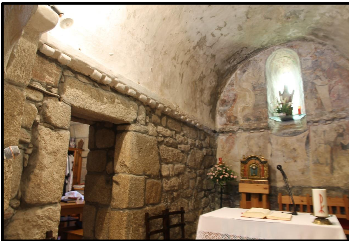
184. Bóveda de cañón y línea de imposta billeteada
