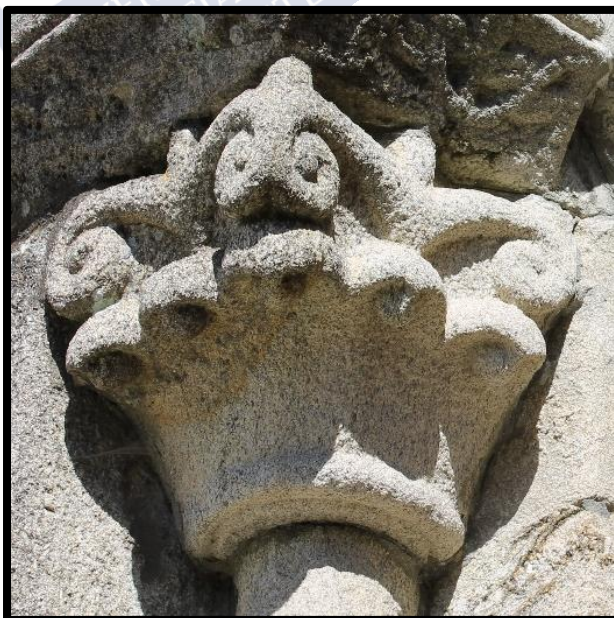
25. Capitel del acceso occidental de Sobrán, con hojas anchas de nervio marcado, terminadas en pomas y con caulículos muy desarrollados
