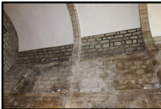
235. Vista del muro sur de la nave
