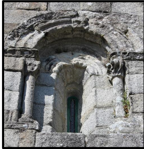
216. Vano del primer tramo, muro sur
