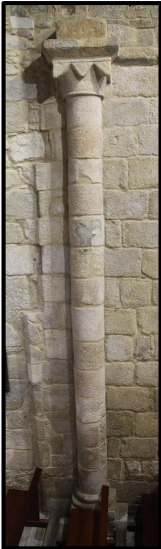
124. Columna de la nave
