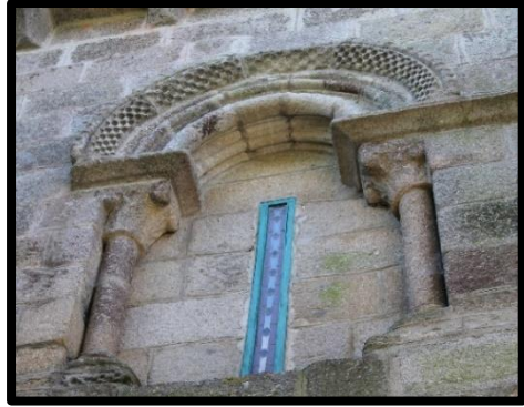
222. Vano del tercer tramo, muro norte
