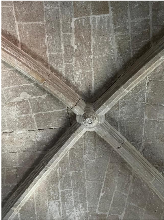
Fig. 72. Bóveda de crucería de la sacristía de la Capilla de San Telmo. Catedral de Tui. [20/06/2025].
