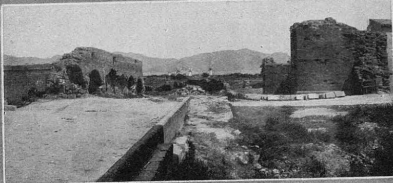
Parte demolida para ensanche del pueblo
