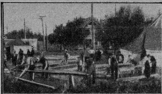
Preparando el material de construcción en un campo adyacente
