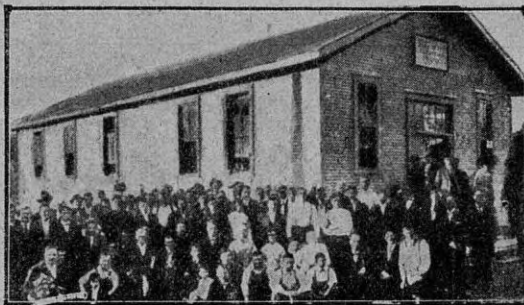
6 p. m. — La iglesia terminada y los obreros que la construyeron
