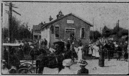
4 p. m. — Colocación de puertas y ventanas
