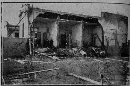
Interior del edificio derrumbado
