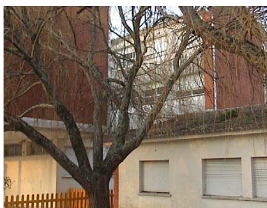
Foto 6: Patio lateral exterior
