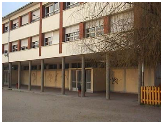
Foto 8: Fachada Principal (Puertas de entrada)
