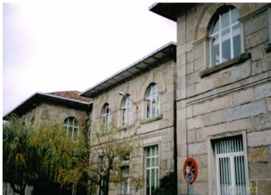
Foto 17: Fachada Edificio "Anexo"
