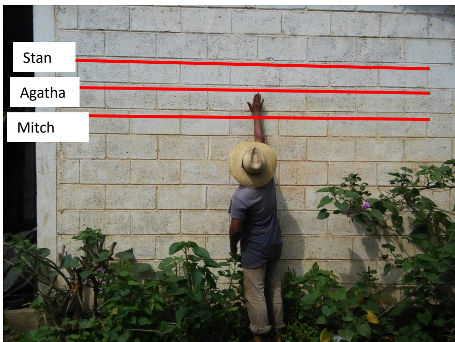
Lám. 14. Vivienda del Sr. Menchú en comunidad Línea B20 señalando el nivel de la inundación influenciada por Agatha en la parte baja de la cuenca Sis-Icán.
