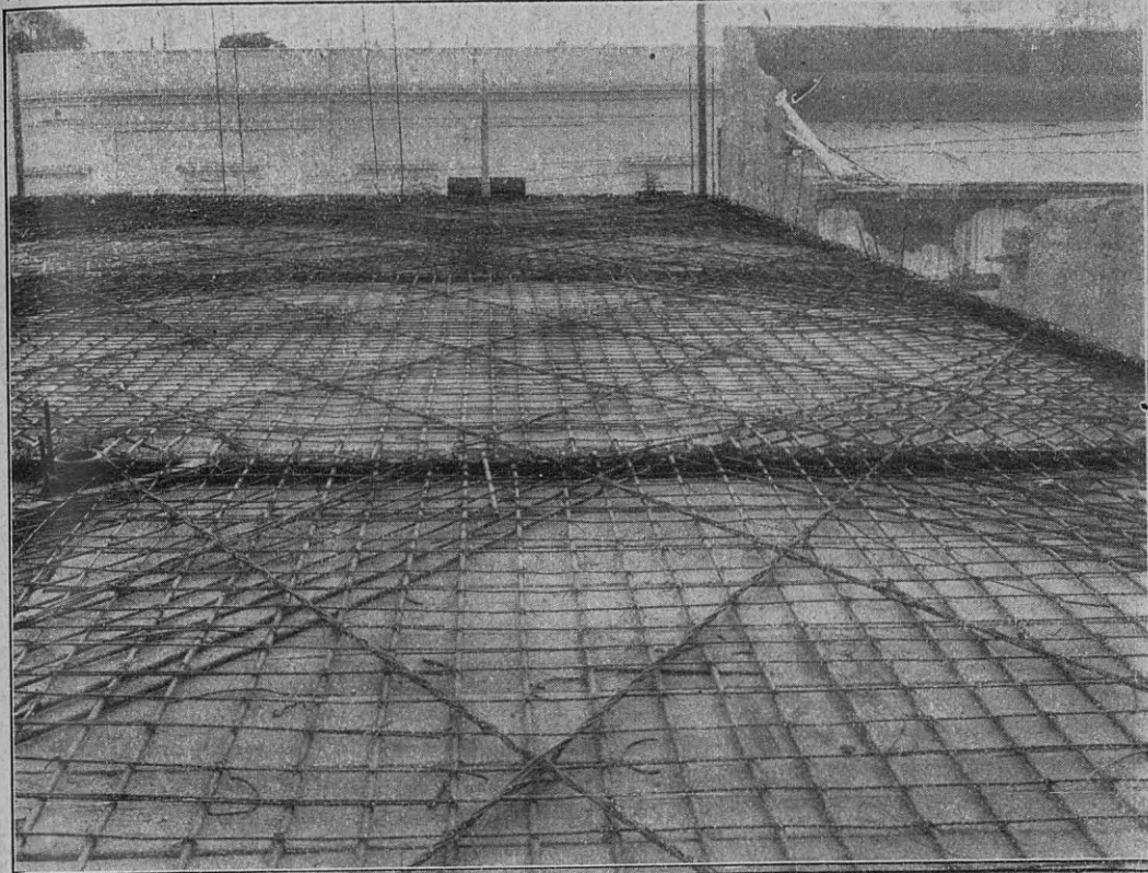
Armazón de un techo en cemento armado
