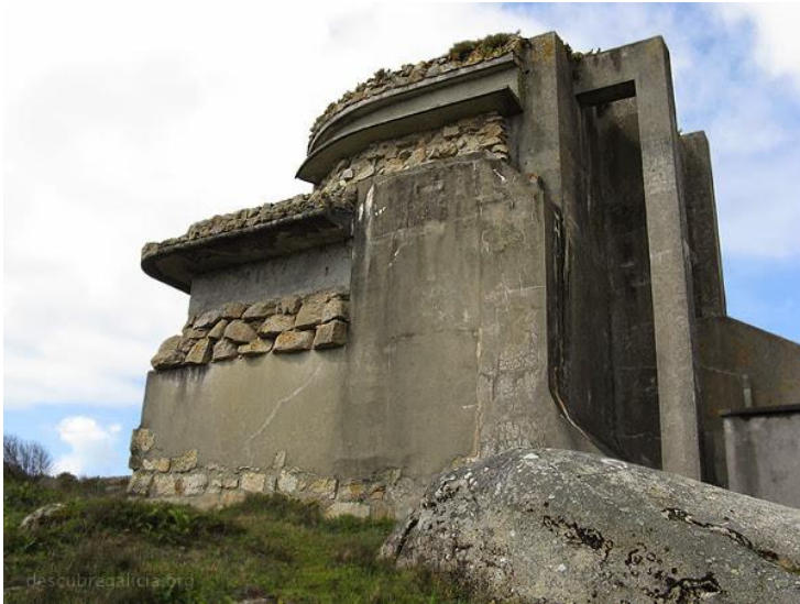
Fig. 6. Puesto de Telemetría de la Batería J-1- Fuente: Calavera, M. (2010). Batería costera J-1 Puerto Cuaces. Diario de mi muerte . https://manuelc2005.blogspot.com/2010/09/12306-bateria-costera-j1-puerto-cuaces.html
