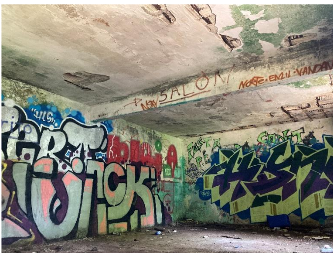
Fig. 19. Grafitis en el interior de las instalaciones de la Batería J-3. Fuente: autoría propia.
