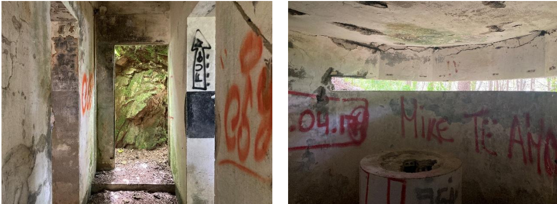
Fig. 17. Interiores del Puesto de Telemetría de la Batería J-3. Fuente: autoría propia.
