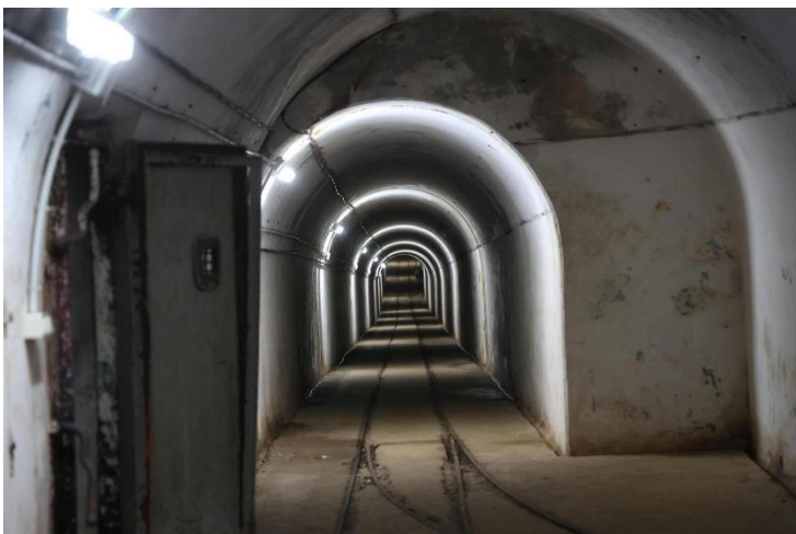
Fig. 8. Interior de uno de los túneles de la Batería J-1. Fuente: Parga, N.; Méndez, M. (2024). Visita a las entrañas de una batería militar: así son sus túneles y cañones. Faro de Vigo . https://www.farodevigo.es/fotos/arousa/2024/03/16/visitas-organizadas-pinchanogrove-bateria-militar-puerto-cuaces-ejercito-99569839.html#foto=1
