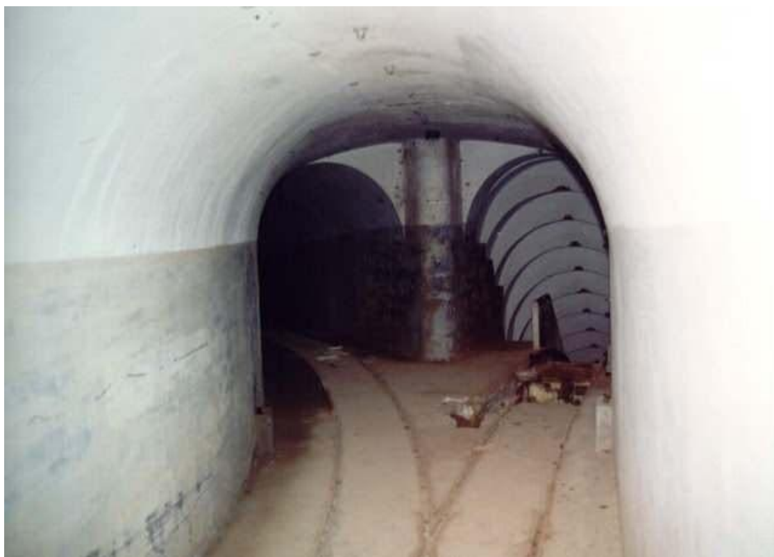
Fig. 30. Raíles para transportar la mercancía dentro de los túneles de la Batería J-4. Fuente: foro online https://www.elgrancapitan.org/foro/viewtopic.php?t=24312&start=30
