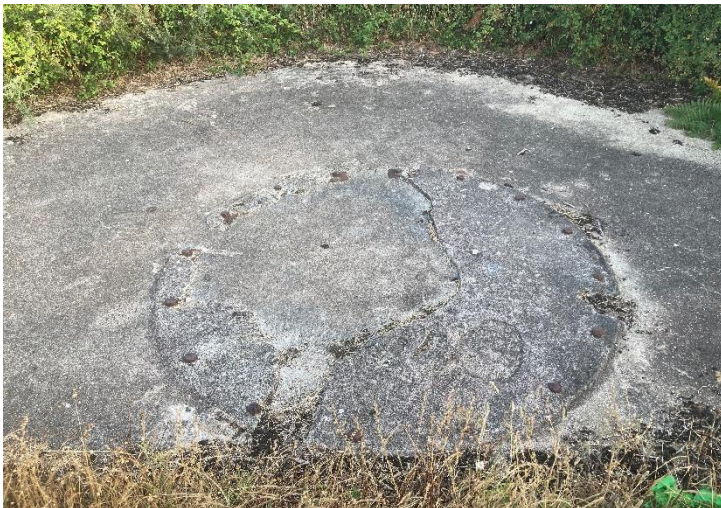
Fig. 13. Estructura de hormigón armado donde se apoyaban las piezas de artillería de la Bateria J-2, con sus correspondientes anclajes todavía visibles. Fuente: autoría propia.
