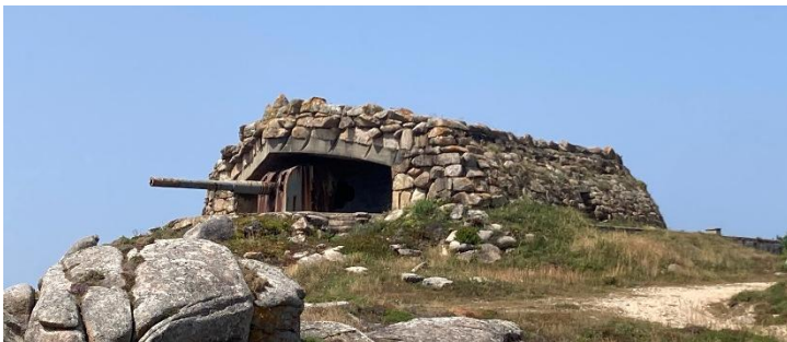
Fig. 5. Casamata de hormigón armado recubierta de piedras que cubre una de las piezas de artillería de la Batería J-1 de Porto Cuaces. Fuente: autoría propia.
