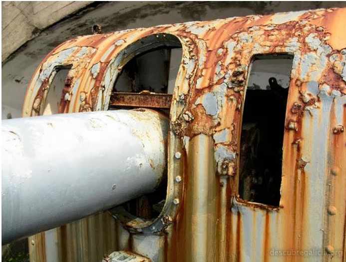
Fig. 9. Muestras de oxidación en los cañones de la Batería J-1. Fuente: Calavera, M. (2010). Batería costera J-1 Puerto Cuaces. Diario de mi muerte . https://manuelc2005.blogspot.com/2010/09/12306-bateria-costera-j1-puerto-cuaces.html
