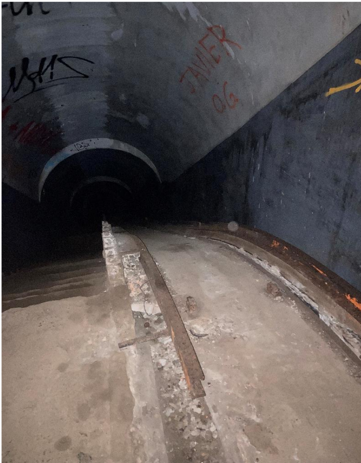
Fig. 31. Sistema de rampas y escaleras en la red de túneles de la Batería J-4. Fuente: autoría propia.
