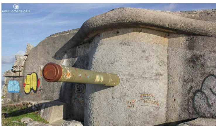
Fig. 25. Casamata de hormigón armado sellada de uno de los cañones de la Batería J-4. Fuente: Rodríguez Serantes, M.; Alonso de Dios, A. (s.f.). Ruinas del cuartel militar de Cabo Silleiro – Batería J4-J5. Galicia Máxica . https://www.galiciamaxica.eu/galicia/pontevedra/baterias/
