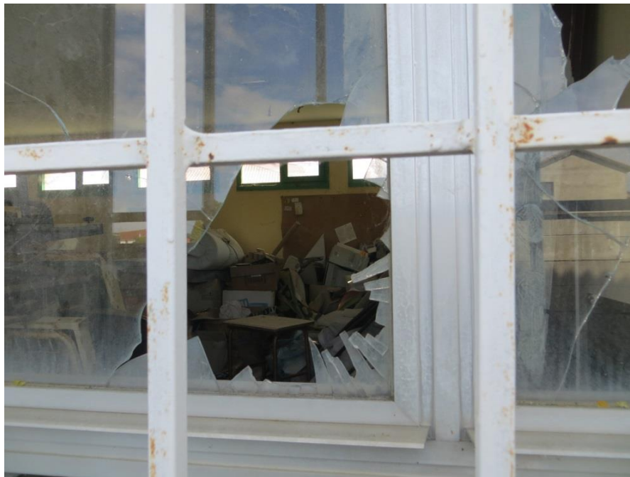
Imaxe 2. Vista do interior da antiga escola de As Feiteiras.
