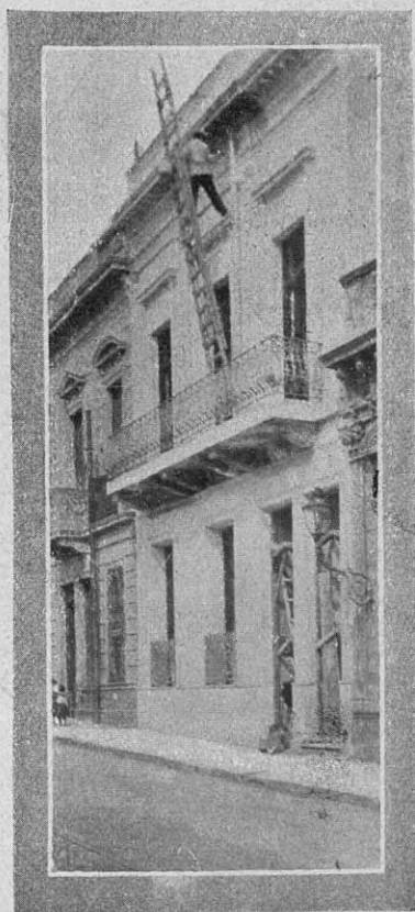
El pintor de escalera
