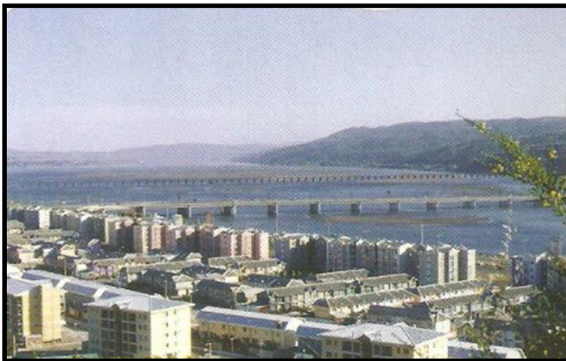
Imagen 6: Vista Panorámica del viaducto vehicular y peatonal, Puente Juan Pablo II y del río Biobío. Concepción–Chile. (Es el primer puente que se aprecia en la fotografía. Es el más largo de Chile).
