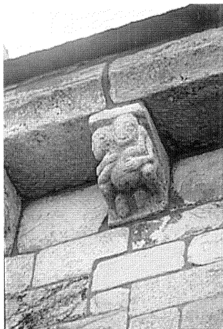
Fig. 5. San Martiño de Mondoñedo (Lugo), muro norte, alero, canecillo n° 8 (W-E).
