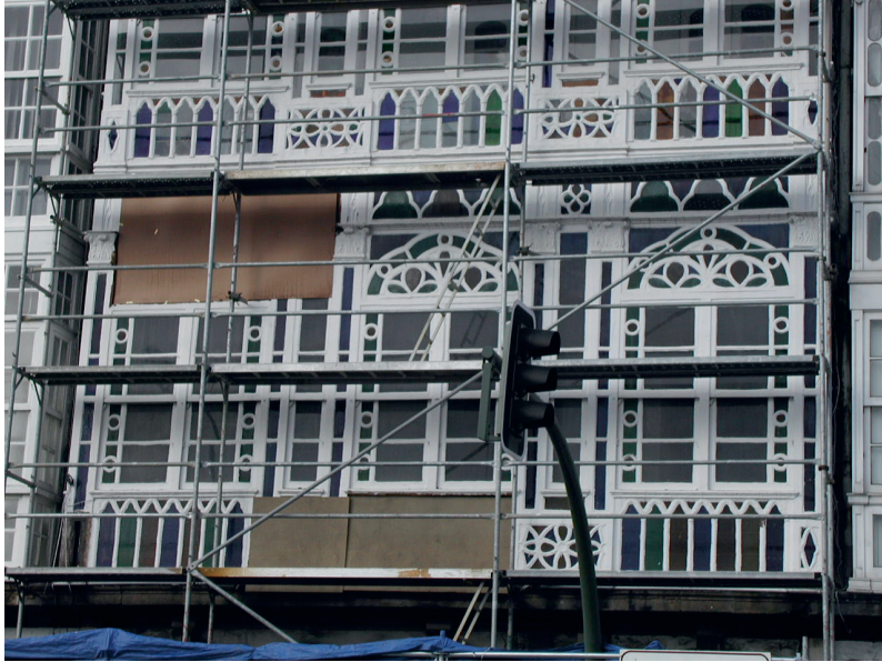
Fig. 18. Inicio de la sustitución de las galerías en enero de 2005 (Foto: autor)
