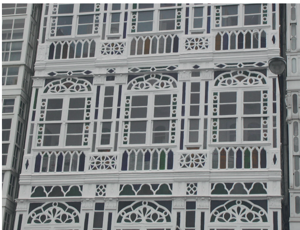
Fig. 10. Detalle de las galerías del número 25-27 de Rego da Auga antes de la restauración en 2005 (Foto: autor)
