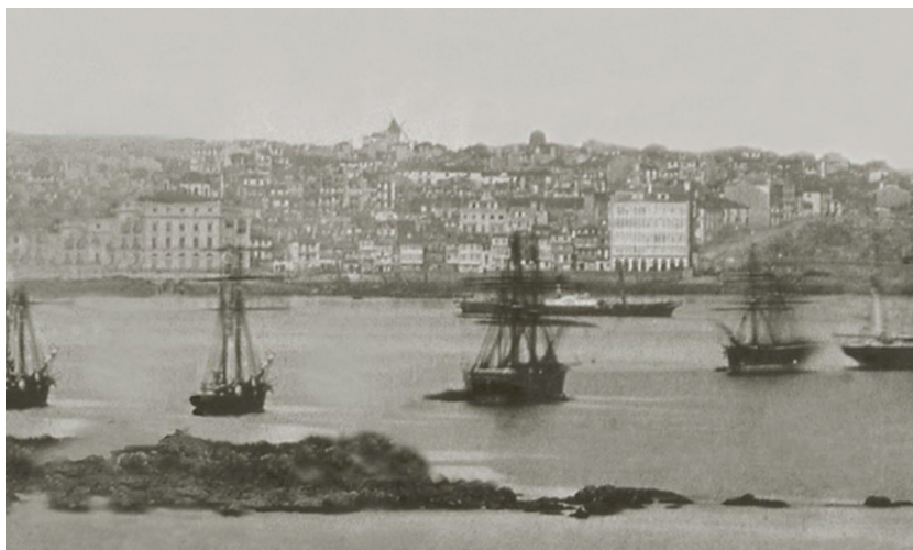
Fig. 2. Sección de la fotografía panorámica de Avrillon correspondiente a la Marina, 1868. Los edificios de la calle Luchana, antes de la ampliación de esta vía, se situaban entre el Teatro Principal y la casa de Augusto José de Vila (AMC. Vista general de A Coruña [Avrillon] ca. 1868)
