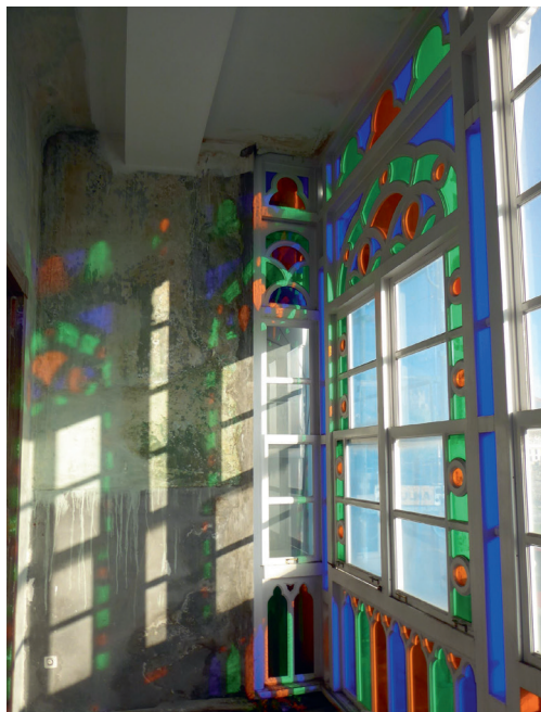
Fig. 11. Reflejos interiores en la galería del primer piso a la Marina en la actualidad (Foto: autor)
