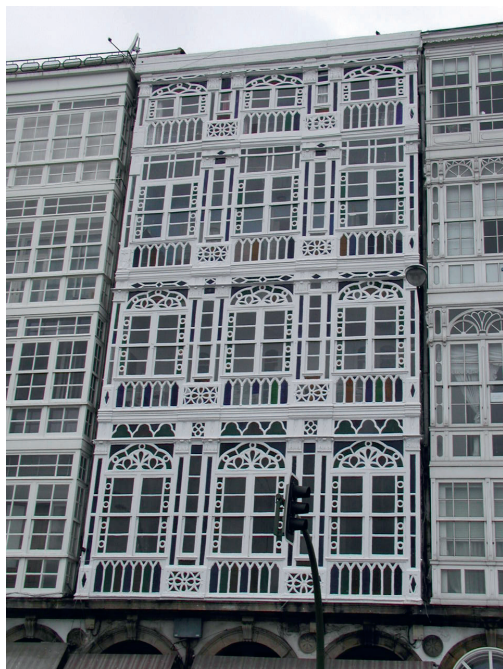
Fig. 17. Estado de las galerías en 2003 (Foto: autor)
