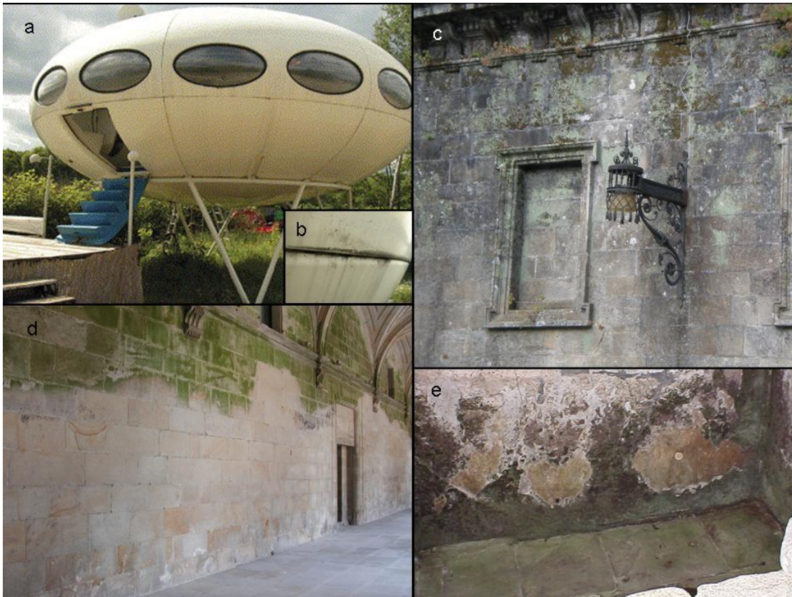
Figura 2. Diversidad de biofilms subaéreos (terrestres). (a) “La casa de esquí”, también llamada “La casa del futuro” o “Futuro”, diseñada por el arquitecto finlandés Matti Suuronen en 1965 en Múnich (Baviera, Alemania). Su exterior, compuesto por plástico y fibra de vidrio reforzada con poliéster, poliuretano-poliéster y polimetacrilato de metilo (plexiglás), presenta una visible colonización biológica. Se trata de un ejemplo de la presencia de biofilms en objetos de arte contemporáneo. (Imagen extraída de Cappitelli et al. , 2006). (b) Detalle del exterior de “Futuro”, mostrando una zona de crecimiento del biofilm formado esencialmente por cianobacterias y arqueas (Cappitelli et al. , 2006). (c) Detalle de la fachada este (donde se encuentra ubicada la Puerta Santa) de la Catedral de Santiago de Compostela (A Coruña, España), construida en su totalidad en roca granítica. La colonización biológica en esta zona es variada con presencia de briófitos, líquenes, algas y cianobacterias. (d) Detalle de la pared con un abundante verdín en la parte superior del claustro del monasterio de San Martín Pinario situado en Santiago de Compostela (A Coruña, España). (e) Detalle de pared y suelo con visible colonización biológica de una de las construcciones de la villa romana de Chedworth, una de las mayores villas romanas en Gran Bretaña, situada en Gloucestershire (Inglaterra).
