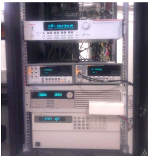
Figura 3.4: Armario con los multímetros y cargas electrónicas.
