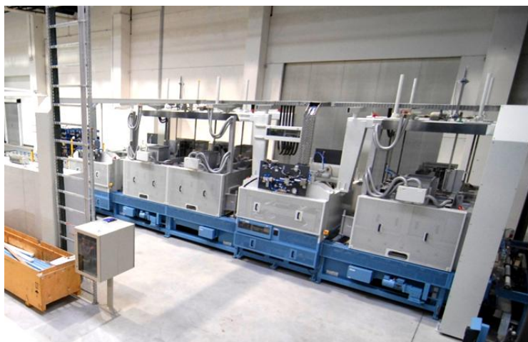
Figura 2.9: Equipo de laminación de los módulos.
