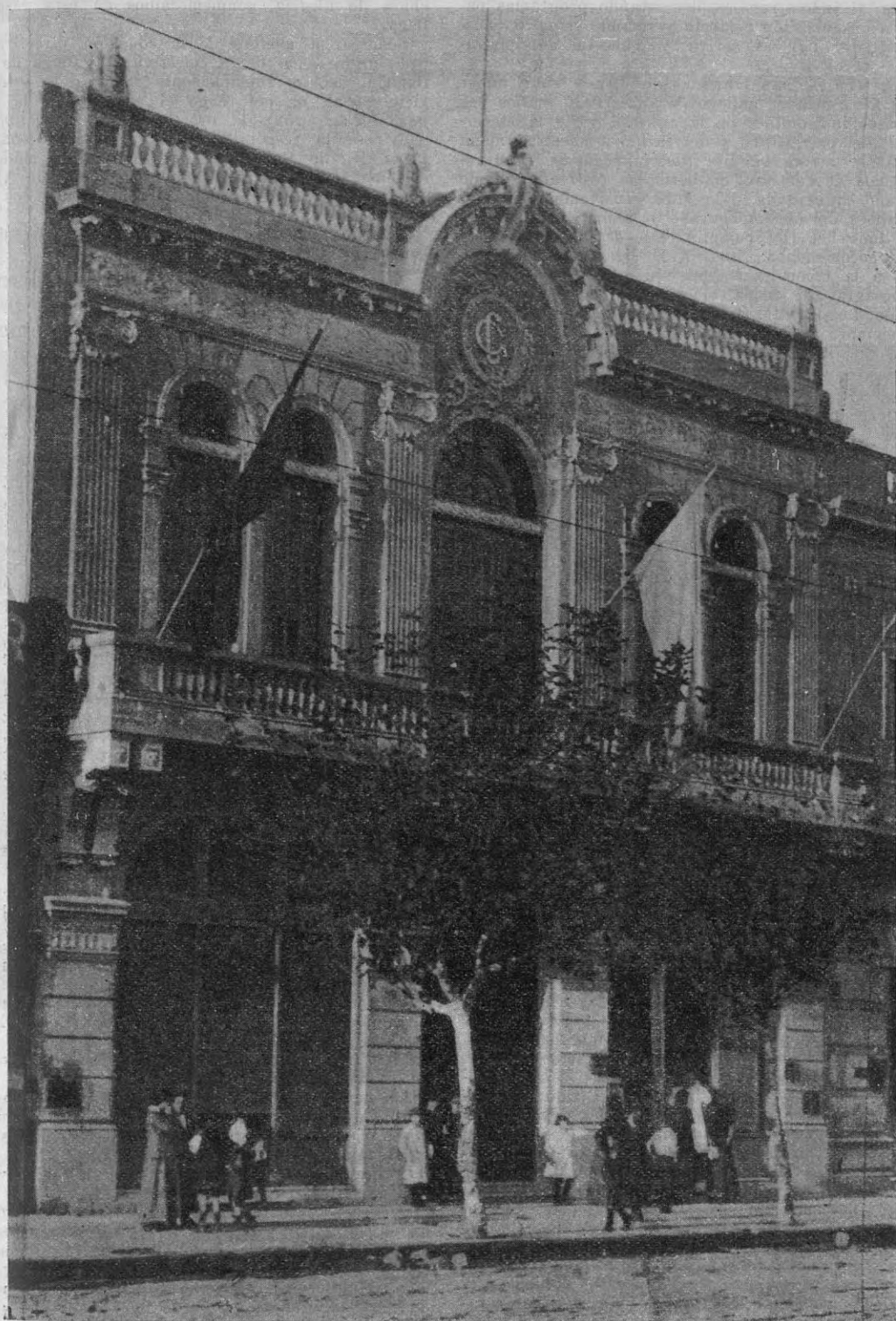
Frente del edificio social
