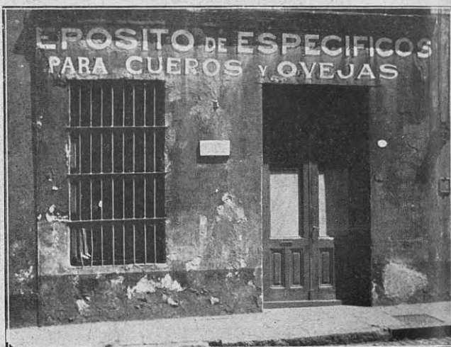
Un letrero que no especifica con suficiente claridad los específicos a que se refiere
