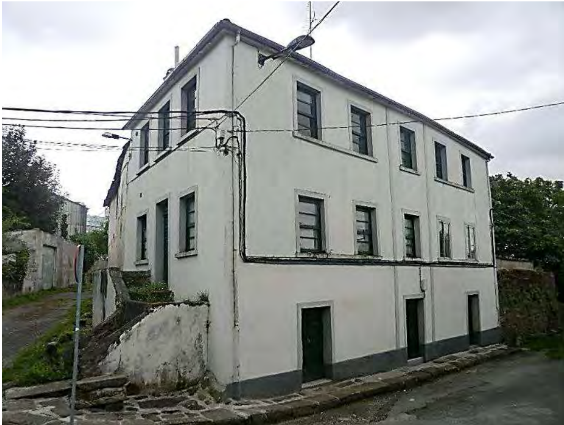
[Fachada principal Rúa do Carme, 25. Lugo], obtenida el 11/2016, de www.sedecatastro.gob.es
