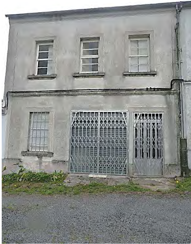
[Fachada principal Rúa do Carme, 62. Lugo], obtenida el 11/2016, de www.sedecatastro.gob.es
