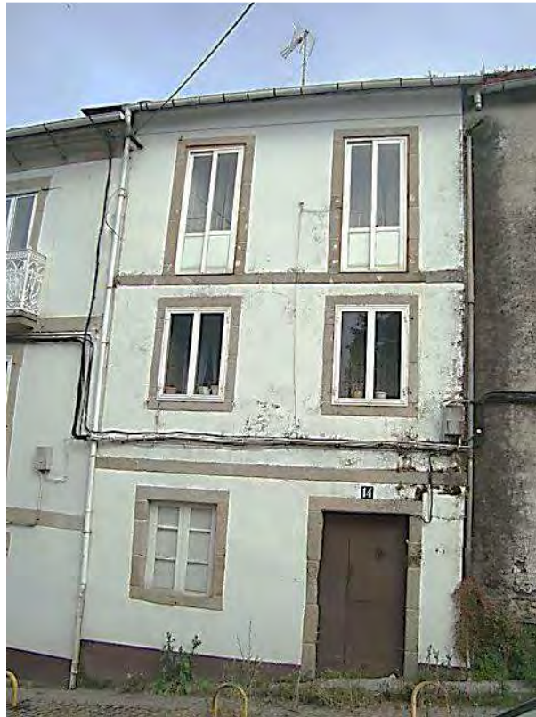
[Fachada principal Rúa do Carme, 14. Lugo], obtenida el 11/2016, de www.sedecatastro.gob.es
