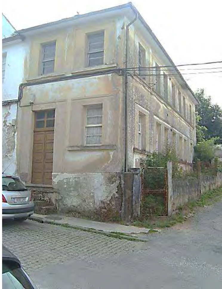
[Fachada principal Rúa do Carme, 23. Lugo], obtenida el 11/2016, de www.sedecatastro.gob.es
