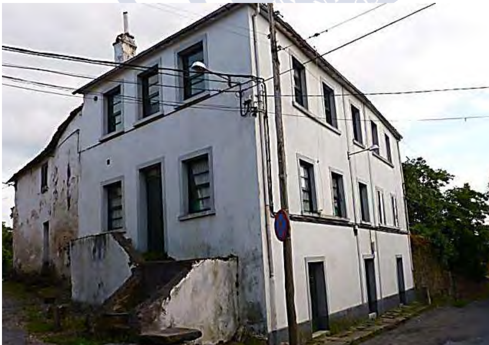
[Imágenes Rúa do Carme, 25. Lugo], obtenidas en el 2010. Archivo fotográfico del autor
