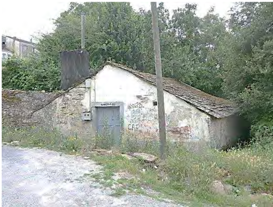
[Fachada principal Rúa do Vicedo, 13. Lugo], obtenida el 11/2016, de www.sedecatastro.gob.es
