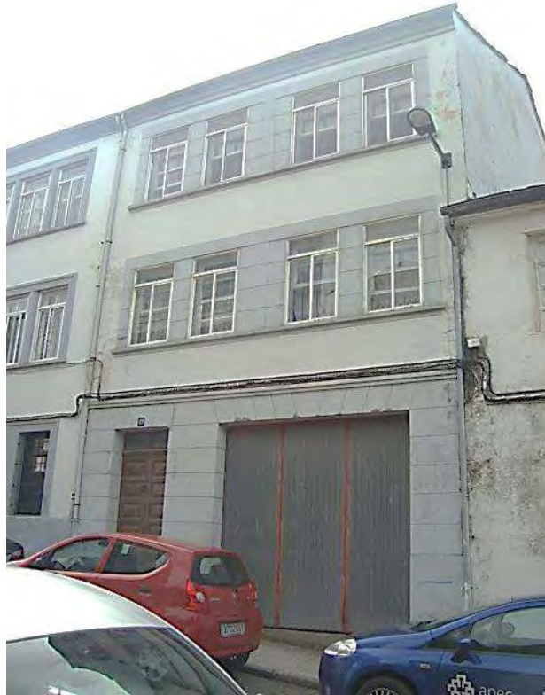
[Fachada principal Rúa do Carme, 19. Lugo], obtenida el 11/2016, de www.sedecatastro.gob.es
