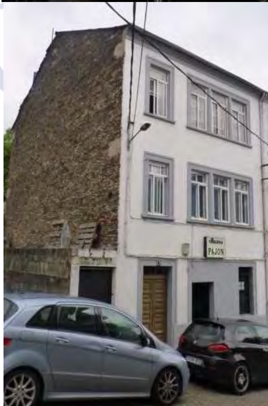
[Imágenes Rúa do Carme, 17. Lugo], obtenidas en el 2010. Archivo fotográfico del autor
