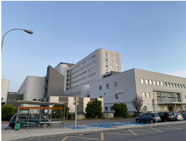
Figura 34. Hospital do Meixoeiro (vista lateral)
