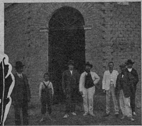
La nueva calle López de Gomara, cuya primera tabilla fué colocada en este almacén de Luciano Lázarro, íntimo amigo de Gomara y uno de sus admiradores literarios
