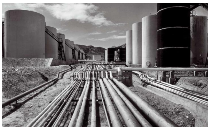
Figura 16. Planta petroquímica REPESA
