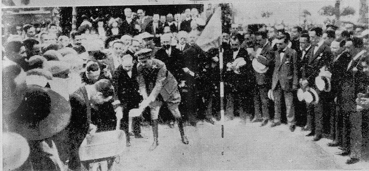
1. El rey en la inauguración de las obras del edificio de Ingenieros industriales. — 2. Don Alfonso inaugurando los trabajos del Metropolitano
