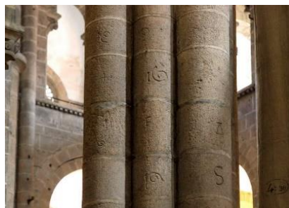
Fig. 2: Marcas realizadas por canteros o peregrinos en algunas de las columnas de la Catedral de Santiago (s.f). URL: http://www.romanicoaragones.com/
