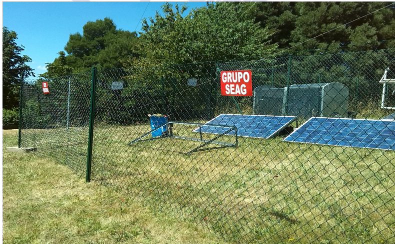
Figura 6.5. Imagen una instalación real alimentada por los módulos fotovoltaicos objeto de estudio y monitorizados en su emplazamiento colindante con la estación meteorológica EOAS de la red MeteoGalicia [73].
