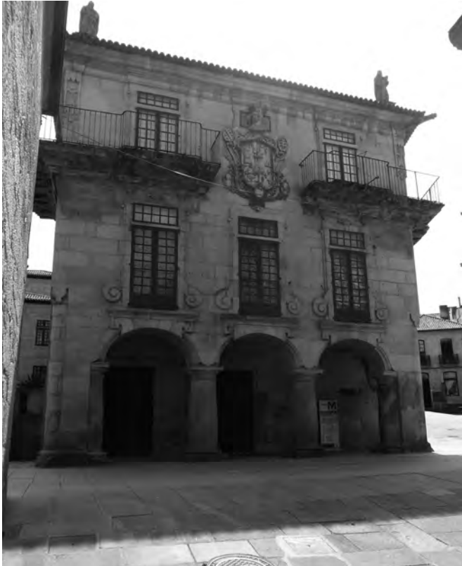
Figura 64. Fachada principal del palacio García Flórez. (F. A.).
