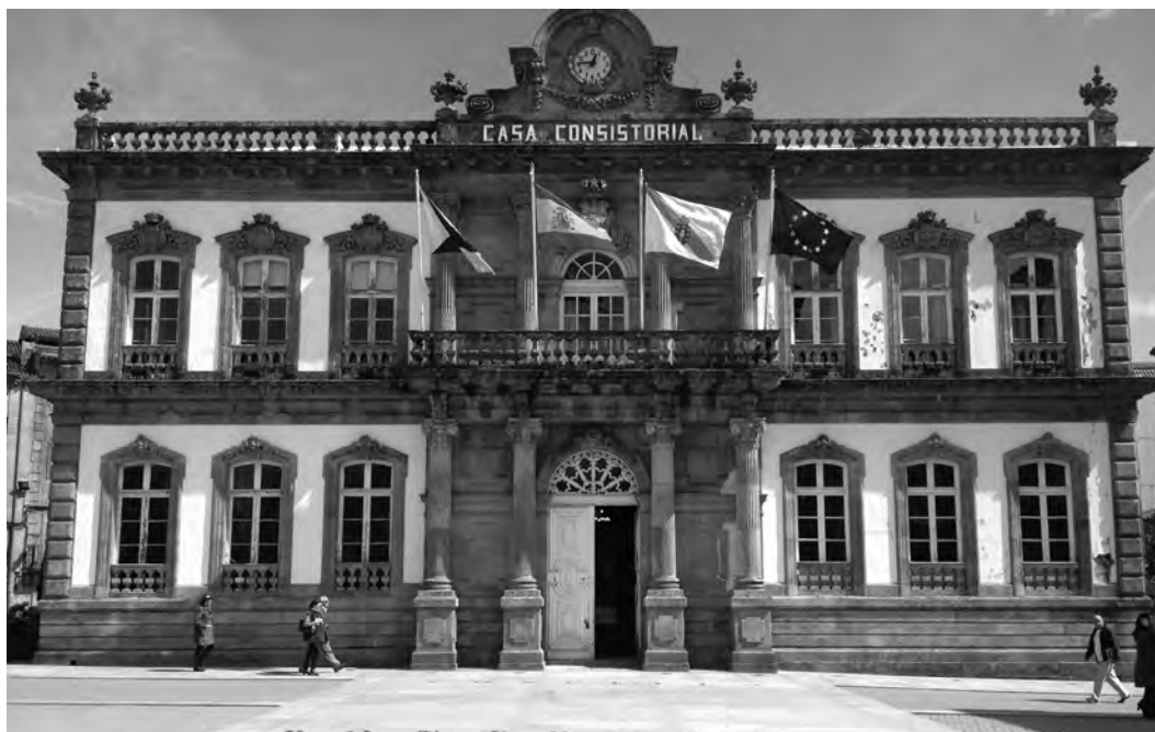
Figura 140. Fachada principal de Casa Consistorial en la actualidad. (F. A.)
