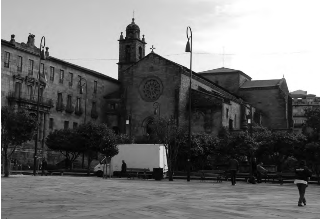
Figura 62. Fachada de la iglesia de San Francisco. (F. A.)
