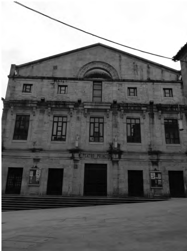
Figura 68. Fachada del Teatro Principal. (F. A.)
