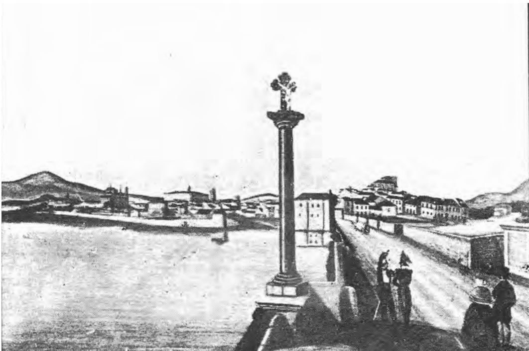
Figura 92. Vista del puente en la primera mitad del siglo XIX. Anónimo
