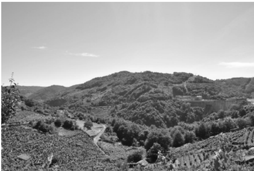
FIGURA 3. VISTA GENERAL DE LA PRESA DE BELESAR
