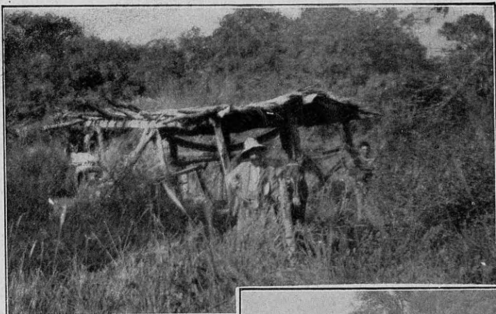
En el kilómetro 65. — Rancho para depósito de material
