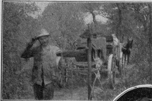
Colocando uno de los mojones de hierro en la picada del paralelo
