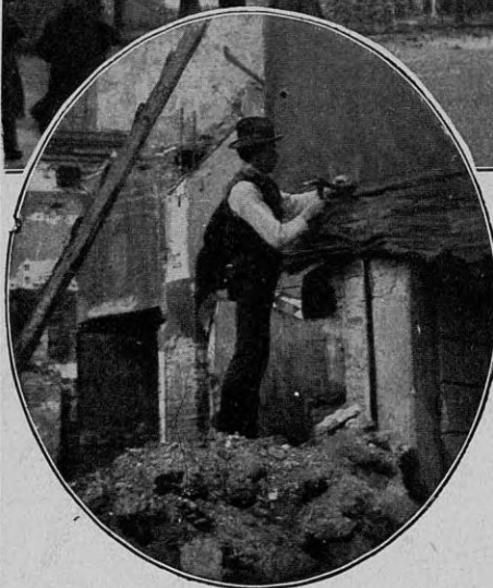
En plena labor destructora
