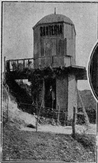
Una santería abandonada que sirve hoy de vivienda al guardián del parque, su perro y su gato
