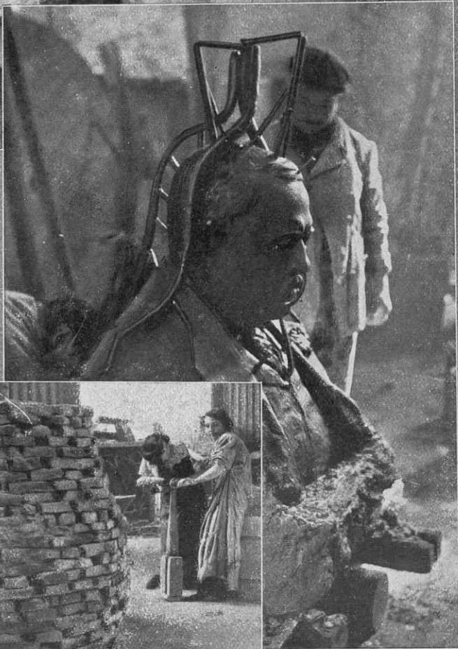
Acto 2.º — Colocando las coladas y el escape de aire en el busto en cera, y cubriendo el conjunto con una mezcla de yeso y polvo de ladrillo
