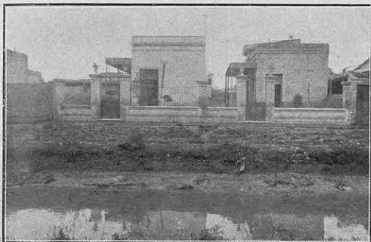
Casa de la calle Monte Dinero, entre Zamudio y Sud-América, perjudicadas en la misma forma
