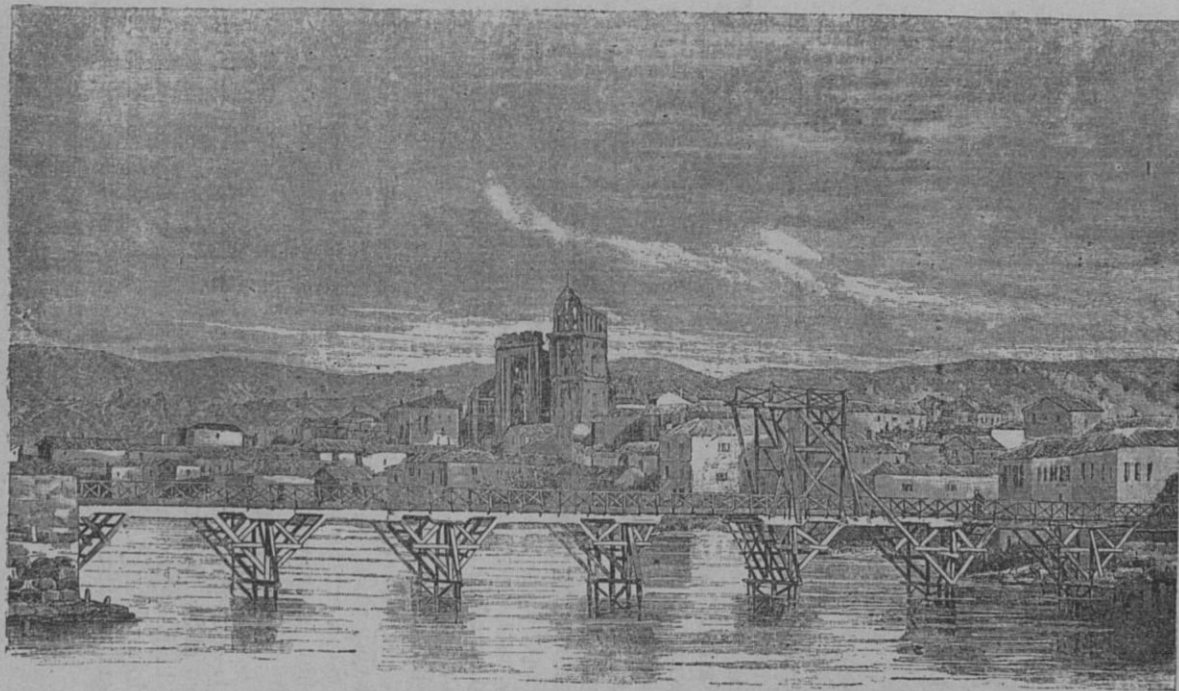
Pontevedra—Puente de Madera y vista de la Moureira
